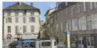
Mise en valeur des arcades du rez-de-chaussée du commerce et travail en douceur sur les toiles d'enduits et des menuiseries (photomontage)
