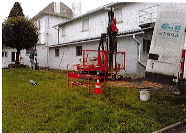
Fondations extension salle polyvalente
