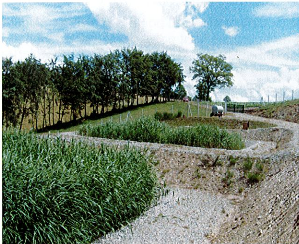
Station d'épuration CITE DES PINS
