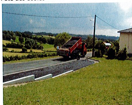
Travaux de voirie à la Cité des PINS
