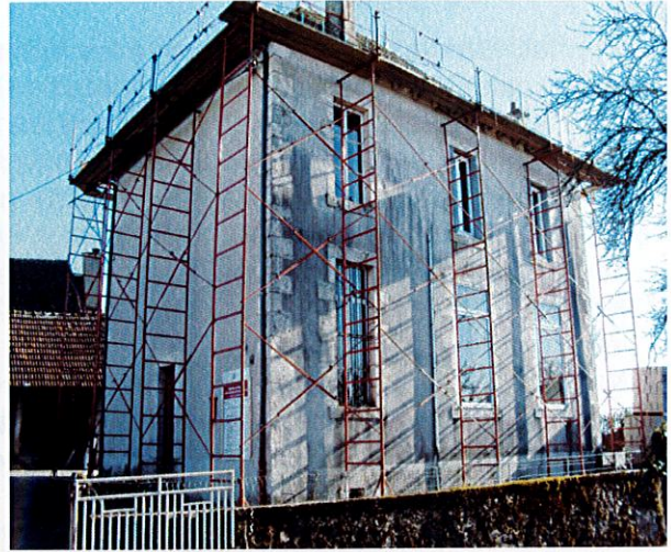
Rénovation ancienne école de MOISSAC
